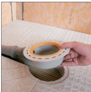
9 ... an Gebäudeentwässerung anschließen.
