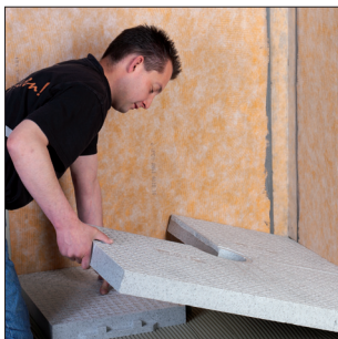
6 Ausgleichs-Board auflegen. Hinweis: Bei Trittschallanforderung Hinweise im Datenblatt 8.6 beachten.
