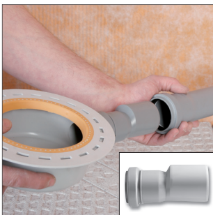
8 Abflussrohr mit Schlüter®-KERDI-DRAIN Ablaufgehäuse verbinden.
