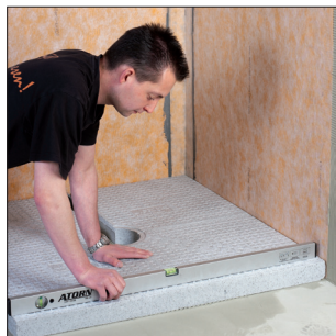
7 Bei Verlegung auf Mörtelbatzen: Ausgleichs-Board mit Wasserwaage ausrichten.
