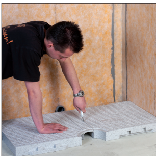
4 Rohrführung mit Cuttermesser herauschneiden.
