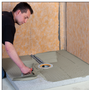
11 Dünnbettmörtel auf Ausgleichs-Board aufbringen.
