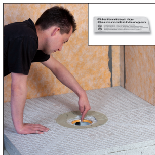
14 Dichtlippe im Ablaufgehäuse mit Gleitmittel versehen.
