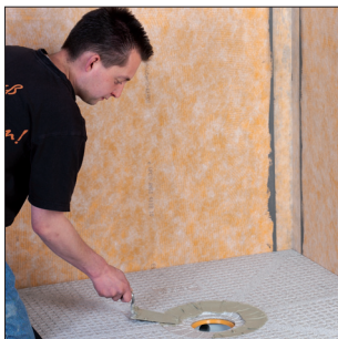
13 Auflagefläche für das Aufsatzelement mit Dünnbettmörtel versehen.
