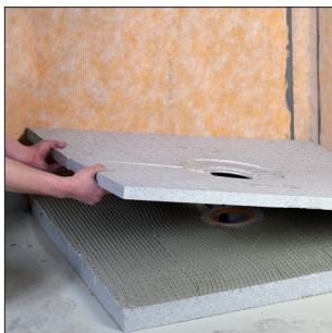
12 b ... und auflegen. (Achtung: Verbindungsstoß nicht auf den darunterliegenden Rohrverlauf).
