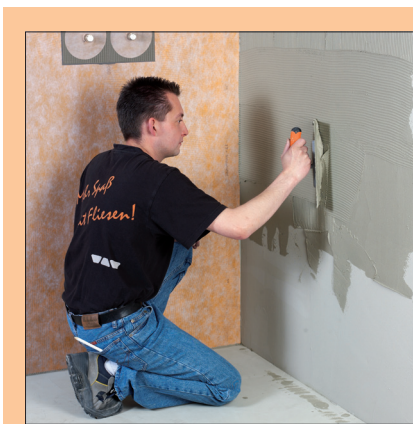
1 Dünnbettmörtel (Zahnung 3 x 3 mm) zur Verklebung der Verbundabdichtung Schlüter®-KERDI aufbringen.
