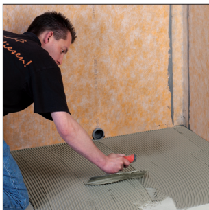
5 Ebenen Flächenuntergrund mit Dünnbettmörtel versehen.
