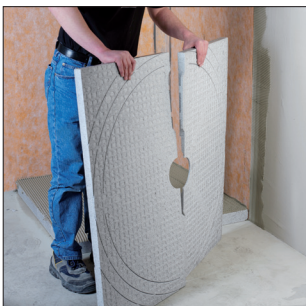
12 a Gefälle-Board zusammenstecken ...
