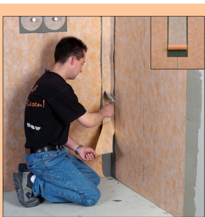
3 Im Stoßbereich mit Schlüter®-KERDI Band unter Verwendung von Schlüter®-KERDI-COLL vollflächig überkleben.
